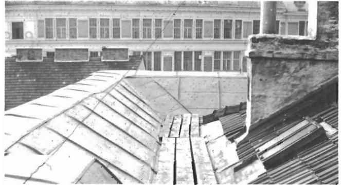
Die Dachhaut bestand aus einer Falzziegeleindeckung, an der Westseite waren Doppelfalzziegel verlegt worden, an der Ostseite Strangfalzziegeln.
