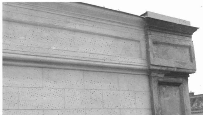
Der Durchfeuchtung des Mauerwerkes oberhalb des Natursteinsockels mußte dadurch Einhalt geboten werden, daß das Ziegelmauerwerk eine Sperrschicht gegen aufsteigende Nässe erhielt. Dies könnte durch verschiedene Verfahren erreicht werden.
